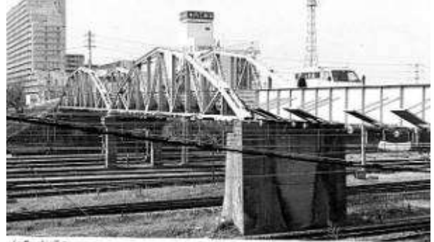
T40081、(旧)小久保跨線橋、兵庫県、明石市、上ヶ池公園、1995
