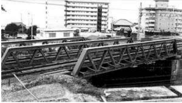
T40021、(旧)舞子跨線線路橋、兵庫県、神戸市須磨区、山陽本線、山陽電気鉄道(部分保存展示)、1917
