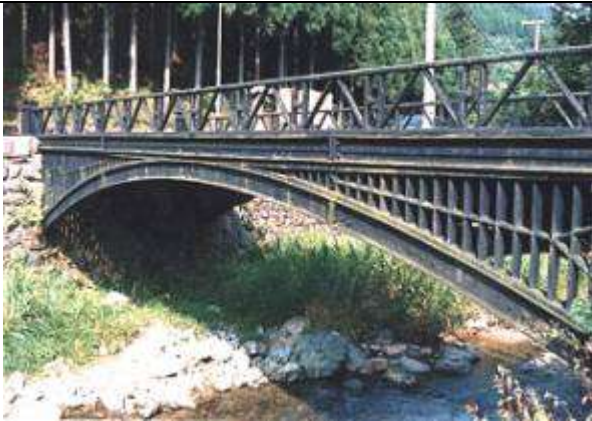
A30011、神子畑橋、兵庫県、朝来町、神子畑川、鑄鉄上路アーチ、
