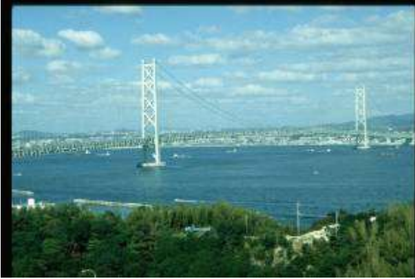
KRS080、明石大橋、JP、明石、吊橋、1998、1991m、 世界最長の吊橋、ケーブルの素線間に空気を通して 防錆をおこなっている
