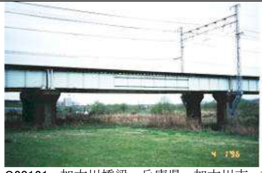
G20121、加古川橋梁、兵庫県、加古川市、加古川、山陽本線、1925
