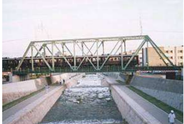
T51722、住吉川橋梁、兵庫県、神戸市東灘区、住吉川、阪急電鉄神戸線、
