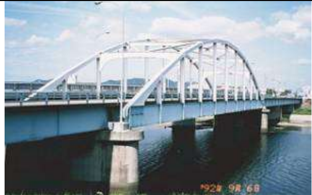
A70271、網干大橋、兵庫県、姫路市網干区余子浜～興浜、揖保(いぼ)川、国道 250 号、1960
