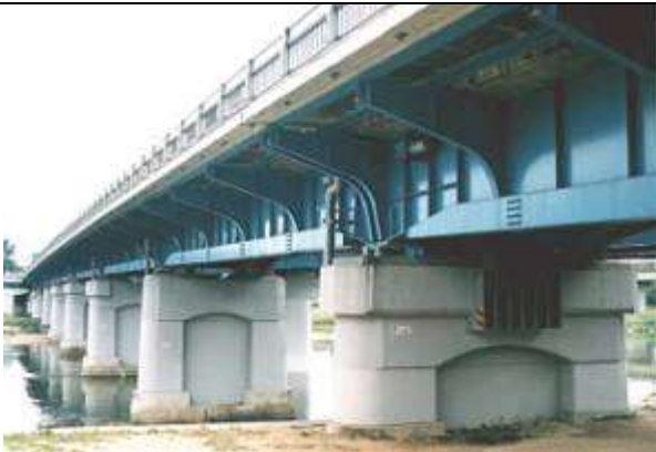
G90021、甲武橋、兵庫県、尼崎市～西宮市、武庫川、国道 171 号、1950
