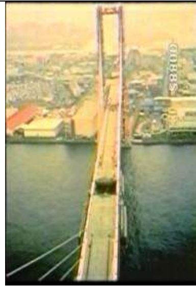
885、YMD910519、東神戸大橋、JP、架設中、 19920500
