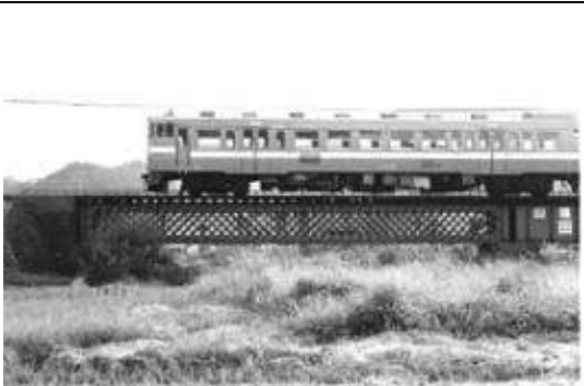
G20101、田君川橋梁、兵庫県、浜坂町、田君川、山陰本線、1912
