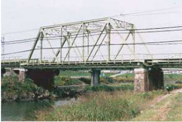
T51711、藻川橋梁、兵庫県、尼崎市、藻川、阪急電鉄/神戸線、
