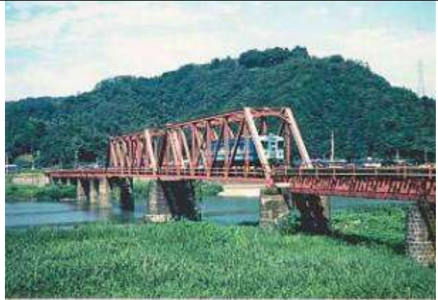
T50951、円山川橋梁、兵庫県、豊岡市、円山川、北近畿タンゴ鉄道/宮津線、1929
