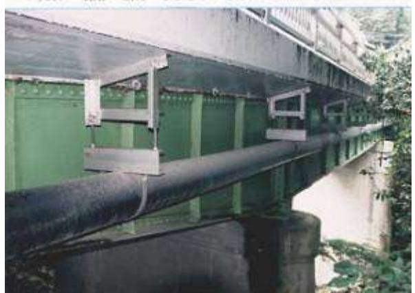
G70611、清瀧橋、兵庫県、神戸市北区、有野川、市道、1934
