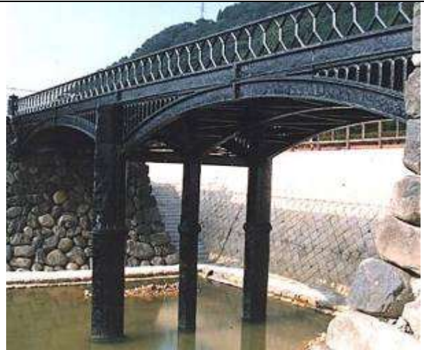
A30021、羽瀨橋、兵庫県、朝来町羽瀨、公園内、鑄鉄上路アーチ、
