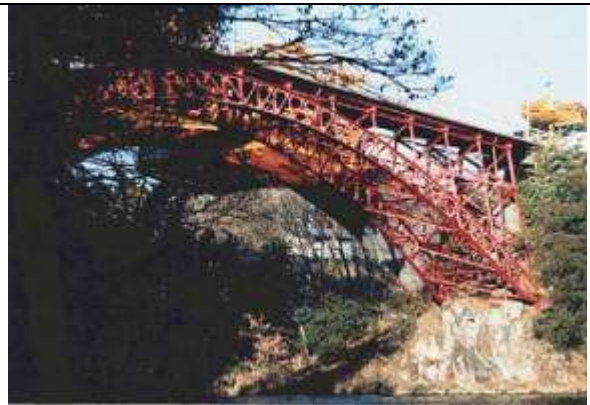
撮影 松村 紳 1995-12-20 A50071、青柳橋、岐阜県、美濃加茂市、飛驒(ひだ)川、県道野上古井線、1927
