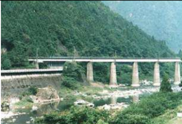
G20051、第一飛騨川橋梁、岐阜県、白川町、飛騨川、高山本線、1928
