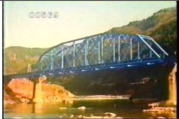
569、BBS9208302、長良川鉄道第5長良川橋梁、JP、岐阜県、八幡町、明治44年建設、トラス橋11、19??????
