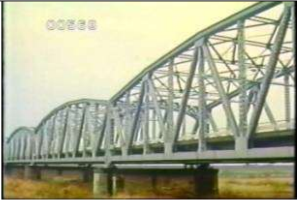
568、BBS9208208、長柄良橋、JP、岐阜県、墨俣町、昭和8年建設、トラス道路橋23、19??????
