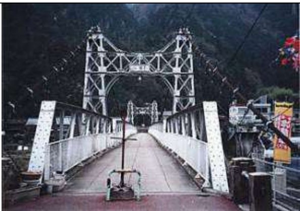
S20033、白川橋、岐阜県、加茂郡白川町、飛騨川、県道、1926
