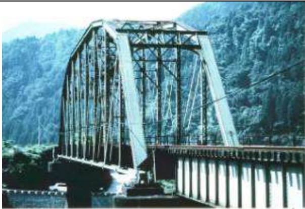
T20191、第五長良川橋梁、岐阜県、八幡町、長良川、長良川鉄道、1960
