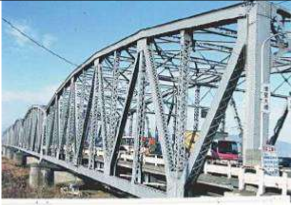
T90781、揖斐大橋、岐阜県、安八町、揖斐川、県道 国道 21 号(建設時)、1933
