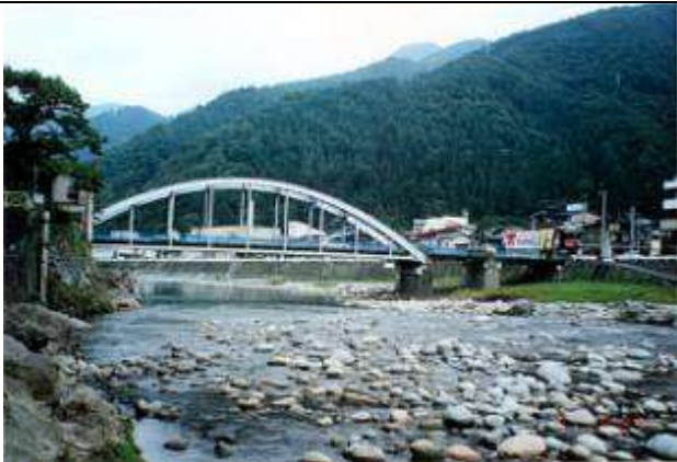
A70032、西里橋、岐阜県、神岡町、高原(たかはら)川、①下路タイドアーチ橋、1951????????
