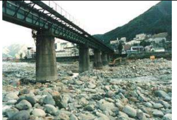
G20061、第六益田川橋梁、岐阜県、下呂町、飛騨川、高山本線、1931
