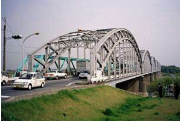
A50591、木曾川橋、岐阜県、笠松(かさまつ)町、木曾(きそ)川、県道柳沢岐阜線(旧・国道 22 号)、1937
