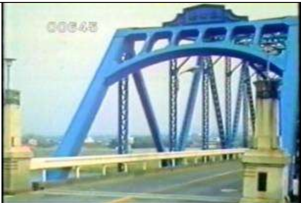
645、BBS9208202、旧太田橋、JP、岐阜県、美濃加茂市、昭和2年建設、トラス道路橋17、19??????
