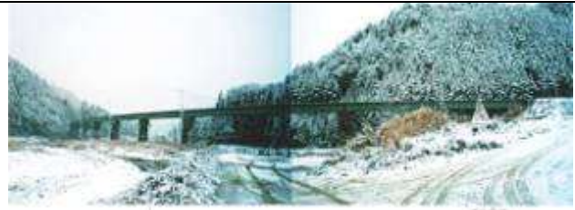
G30031、第二十一益田川橋梁、岐阜県、久々野町、飛騨川、高山本線、1934
