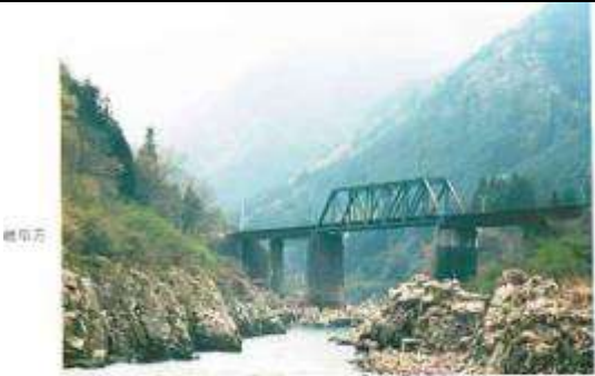
T50981、第一益田川橋梁、岐阜県、金山町、益田川、高山本線、1929
