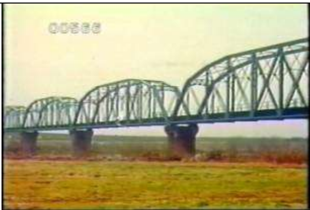
566、BBS9208220、樽見鉄道揖斐川橋梁、JP、岐阜県、大垣市、明治33年建設、トラス橋12、19??????
