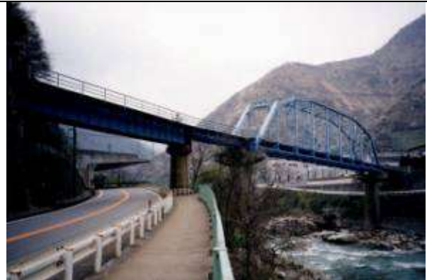
T20222、高原川橋梁、岐阜県、神岡町、高原川、神岡鉱山専用線、1966
