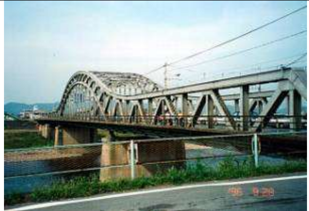
A70011、忠節橋、岐阜県、岐阜市、長良川、県道岐阜～揖斐線(建設時)、1948
