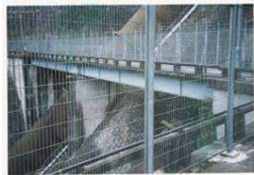
G90101、鉄管跨線橋、岐阜県、加茂郡八百津町、跨丸山発電所水圧鉄管、町道(推定)、1954 撮影 山根 聡 1992年8月 作成 1992-8-10 作成 藤井 郁夫
