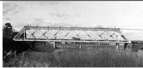
T20071、牧田川橋梁、岐阜県、大垣市、養老町、牧田川、1913
