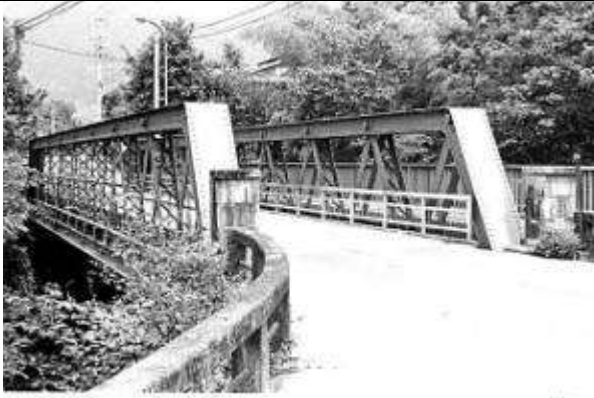
T30021、油皆洞橋、岐阜県、八百津町、油皆洞川、 国道 418 号、1954
