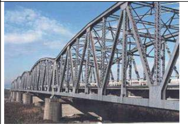
撮影 松村 博 1995年12月19日 T90211、長良大橋、岐阜県、岐阜市、長良川、国道 12 号(建設時) 県道、1933
