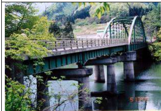
A70071、滝谷川橋、福島県、柳津町、只見(ただみ)川、国道 252 号、1953 撮影 藤井 郁夫 2000-5-13 作成 2006年7月1日 作成 藤井 郁夫
