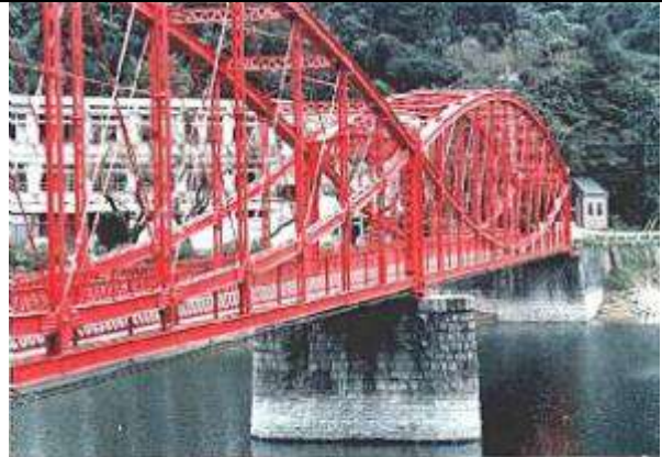
T90021、南河内橋、福岡県、北九州市八幡東区、河内貯水池、下路レンティキュラートラス(ピン結合)、 撮影 岡本 隆敏 1994年 作成 1992-10-10 作成 藤片 徳夫
