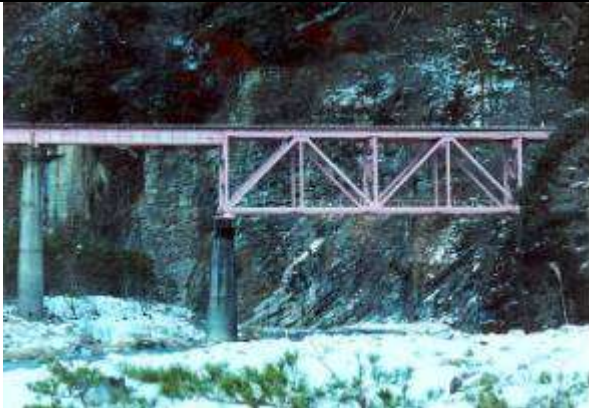
T100341、第二九頭竜川橋梁、福井県、大野市、九頭竜川、越美北線、1960
