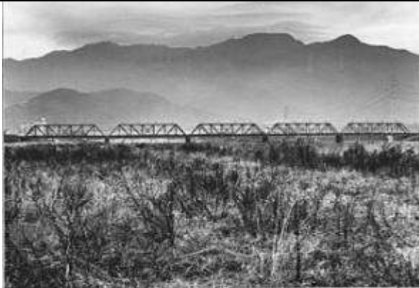
T50091、加茂川橋梁、愛媛県、西条市、加茂川、予讃線、1923
