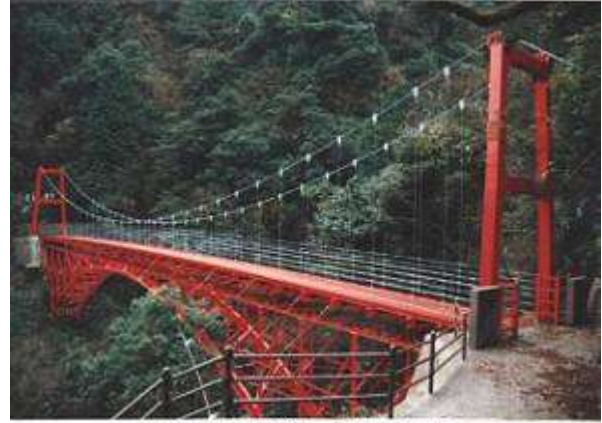
1993年11月26日 撮影 田島二郎 A30031、遠登志橋、愛媛県、新居浜市、国領川支流の小女郎川、スバンドレルトラスドアーチ、
