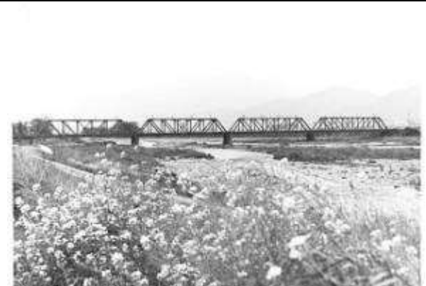
T50491、中山川橋梁、愛媛県、東予市、中山川、予讃線、1923
