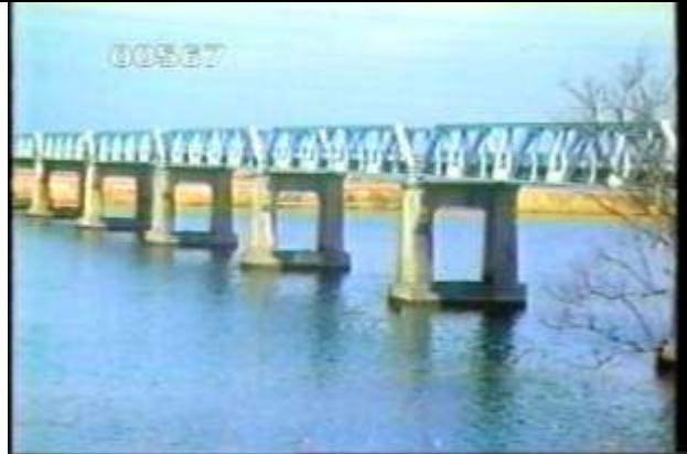
567、BBS9208212、中畑橋、JP、愛知県、碧南市、昭和10年建設、トラス道路橋6、19??????
