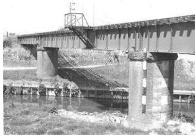
G10021、石ヶ瀬川橋梁(貨物線)、愛知県、大府市、東浦町、石ヶ瀬(いしがせ)川、
