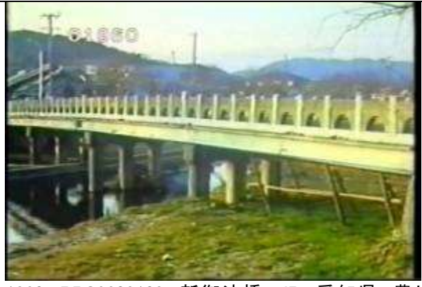
1860、BBS9208108、新御油橋、JP、愛知県、豊川市、昭和3年建設、コンクリート桁17、19??????
