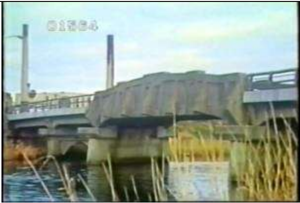
1564、BBS9208115、刈谷橋、JP、愛知県、刈谷市、 昭和9年建設、コンクリート桁34、19??????
