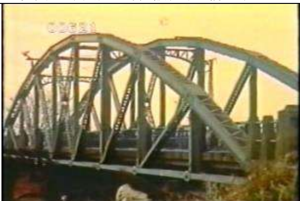
621、BBS9208215、陸田跨線橋、JP、愛知県、稲沢市、明治17年建設、トラス橋1、19??????
