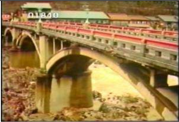
1840、BBS9208315、城嶺橋、JP、愛知県、瀬戸市、昭和12年建設、コンクリートアーチ橋10、19??????
