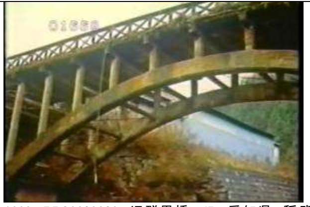
1668、BBS9208306、旧群界橋、JP、愛知県、稲武 町、大正6年建設、コンクリートアーチ橋5、19??????
