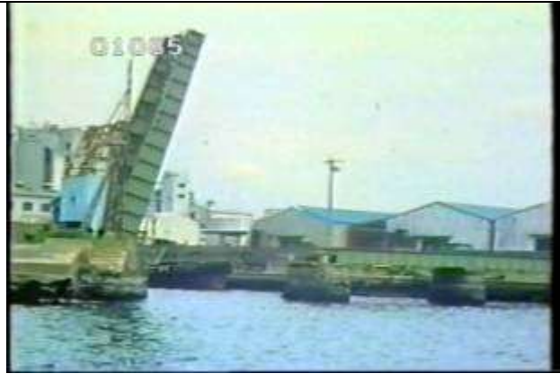
1085、BBS9208104、1、2号地運河可動橋、JP、愛 知県、名古屋市港区、昭和3年建設、鋼桁1、 19??????
