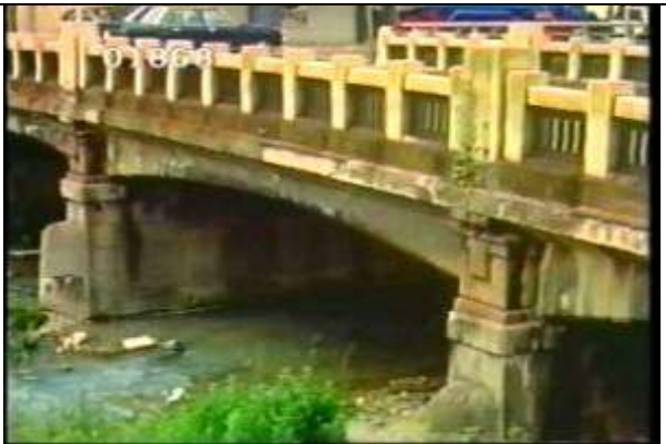
1868、BBS9208107、蔵所橋、JP、愛知県、瀬戸市、昭和2年建設、コンクリート桁、19??????
