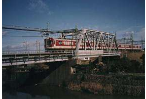
T51852、立田川橋梁、愛知県、弥富町、立田川、近畿日本鉄道/名古屋線、1959
