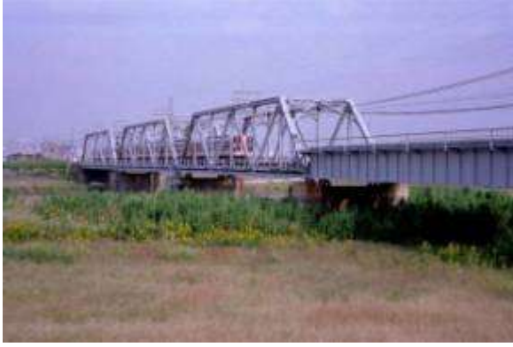
T51821、庄内川橋梁、愛知県、名古屋市中川区、庄内川、近鉄、1938
