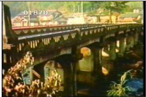
1870、BBS9208110、足助大橋、JP、愛知県、足助町、昭和5年建設、コンクリート桁22、19??????
