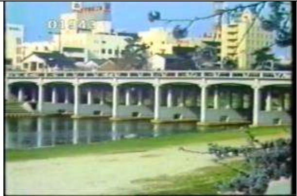
1943、BBS9208105、殿橋、JP、愛知県、岡野市、大 正12年建設、コンクリート桁4、19??????
