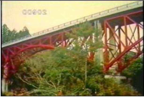
902、BBS9208401、牛湫橋、JP、愛知県、新城市、全景、昭和5年建設、鋼アーチ1、19???? ?
