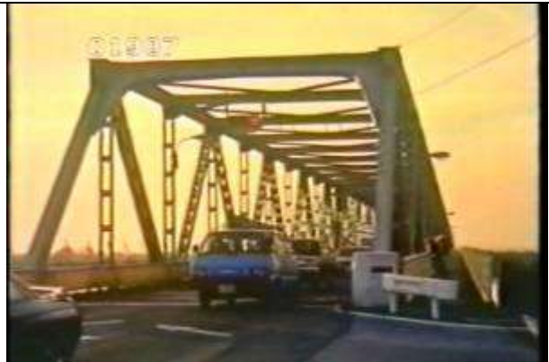
1987、YMD910311、濃尾大橋、JP、左岸側のアプロ ーチ、19911200
