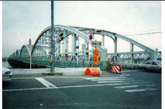
A50381、尾張大橋、愛知県、弥富町、木曾(きそ)川、国道1号、1933
