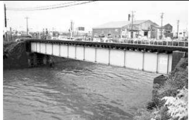
G10261、神戸川橋梁、愛知県、半田市、神戸川、武豊線、1891
