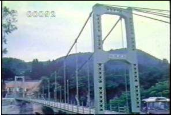
92、全景、L=102m、b=3.4m、f/L=1/10、無補剛吊橋
