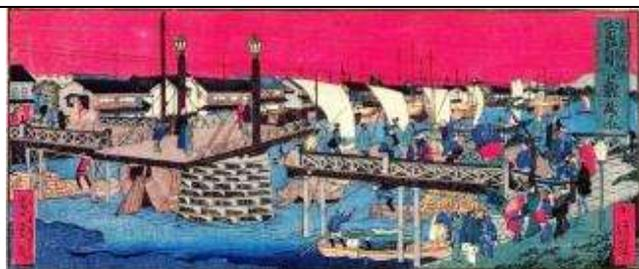
MK519. 磁石橋。「浪花名所安治川口新橋の景」。1873。小信。帆柱を持つ船の通行のため、鉄製の水平に回転する可動橋が作られた。磁石橋と呼ばれた。大阪開化絵
