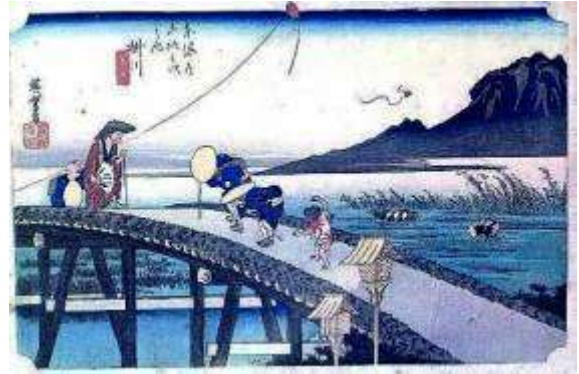
図12. 東海道五十三次 掛川(広重) 木の丸太を横に並べ、土を盛って舗装しました。
