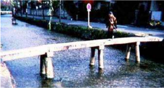
図11. 行者橋(京都)。幅は60cmの石の桁橋です。橋の上で人のすれ違いができません。
