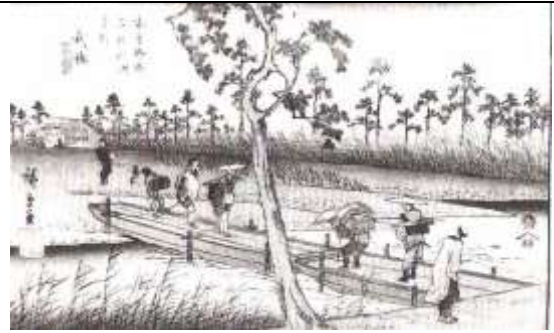
AMN06:舟橋:広重画「木曾街道六十九次之内武佐」(東京国立博物館):簡単な舟橋の構造が具体的に解る。
