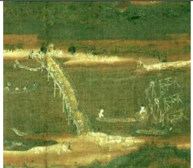
AMN18: 山崎橋: 山崎架橋図(和泉市久保惣記念美術館): 淀川に架かる山崎橋は、行基菩薩が架けたが、何度も流された。平安時代に架け直されたときの物語りを鎌倉時代に絵にしたものである。この絵の中には、行基菩薩にまつわる種々の伝説を象徴的に描いてあるので、絵解き(絵の解説)が下に付けられている。
