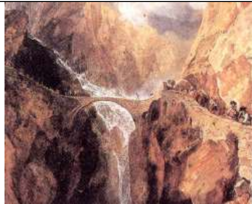
AMN50: ターナーが描いたアンデルマットの悪魔の橋。中世ヨーロッパの各地に橋を造ったのは架橋騎士団と呼ばれる修道僧の集団だった。神の助力なしに、こんな所に橋を架けることができるのは悪魔以外にないと考えられたことからこの呼び名ができた。
