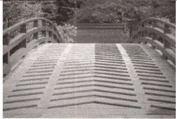
AMN24: 神橋: 太鼓橋の構造: 神社や寺院には太鼓橋が架かっていることが多い。この宗教的な意味は、聖なる敷地と俗界とを隔てる池や川を渡す。通常の人馬の通行を考えないので、傾斜がきつい。橋の路面は、滑り止めがついている。
