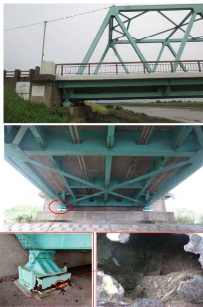
写真-1. 現況状況
