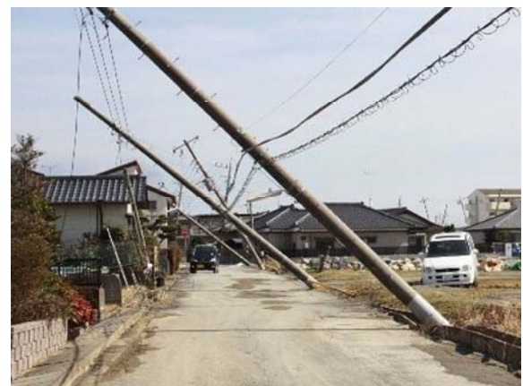
写真16 沈下傾斜した電信柱(2011/3/12撮影)
