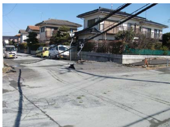
写真11 垂れ下がった電線による交通障害の状況(2011/3/12撮影)
