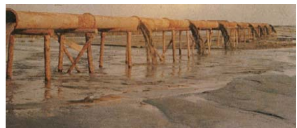
写真4 1970年当時のポンプ圧送の様子 5)
