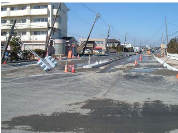
写真19 4車線道路の施工中区間の被災状況(2011/3/12撮影)
