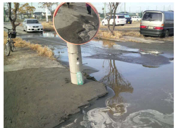
写真17 沈下した電信柱(2011/3/12撮影)
