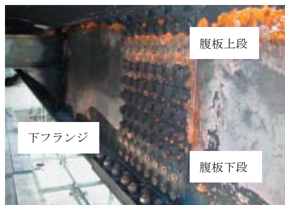
写真-2 主桁添接部 軸力測定箇所
