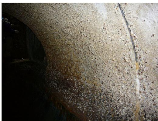
写真1 管の腐食状況
