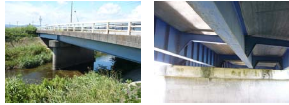
写真-4 野川下橋
