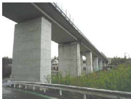
写真-1 実証橋梁
