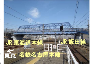
写真-1 架橋状況
