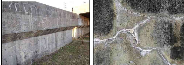
写真-2. RC橋脚躯体の表面写真
