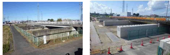
写真-5. RC橋脚の全景 (左：施工前，右：施工後)
