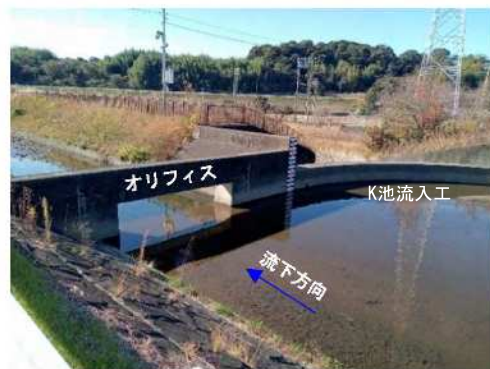
図-4 K池流入工およびオリフィス
