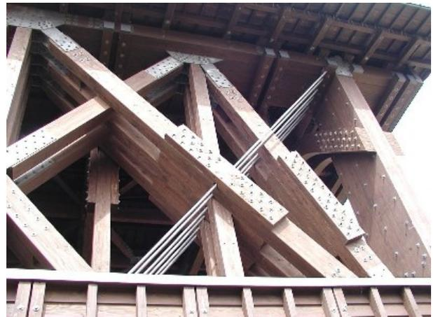
図2 弦材の繋ぎは鋼材とボルトが使われている（同左）
