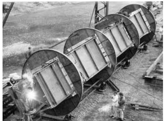
図13. 下向きの溶接作業に使う回転枠
