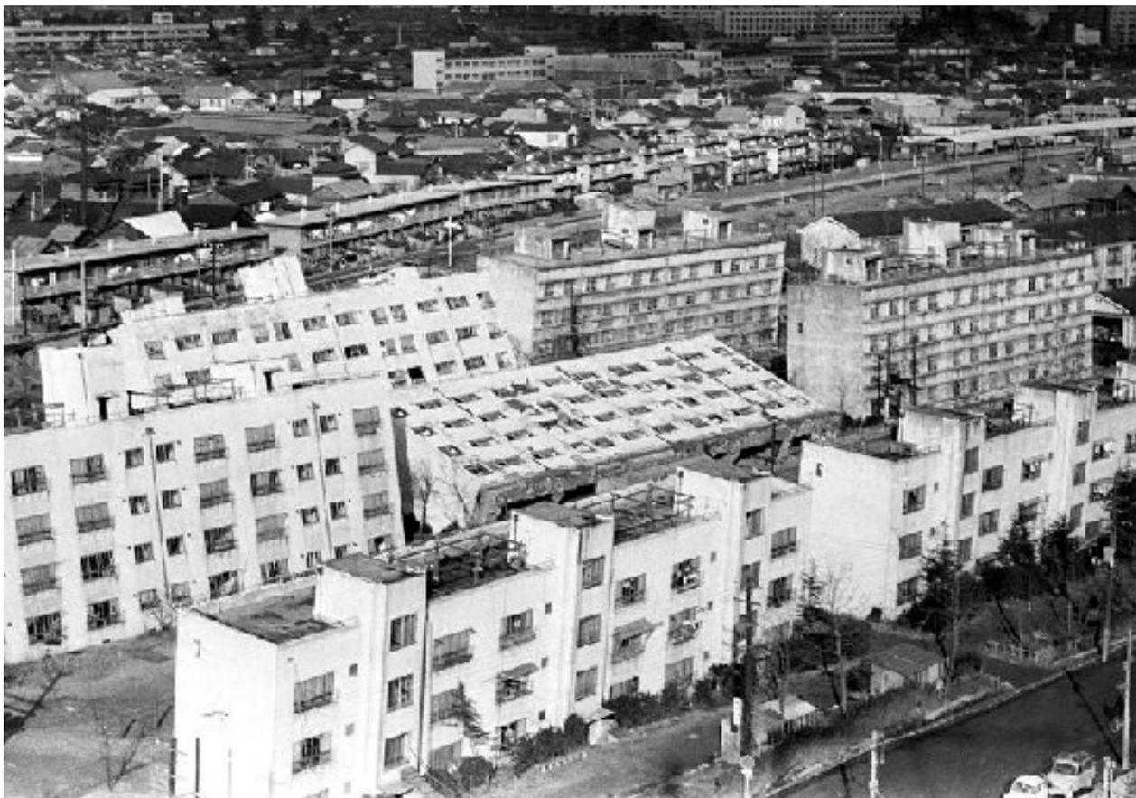
図 11.3 新潟地震時の流砂現象で傾いたアパート群 (西日本新聞)
