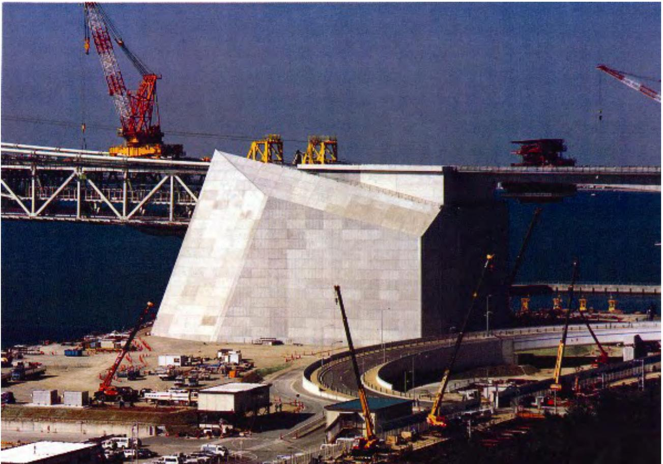
図 11.2 明石海峡吊橋の神戸側アンカーブロック（工事中の写真）
