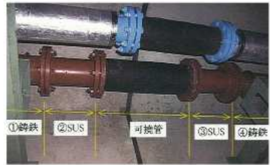
写真-8 放射線透過試験装置測定箇所
