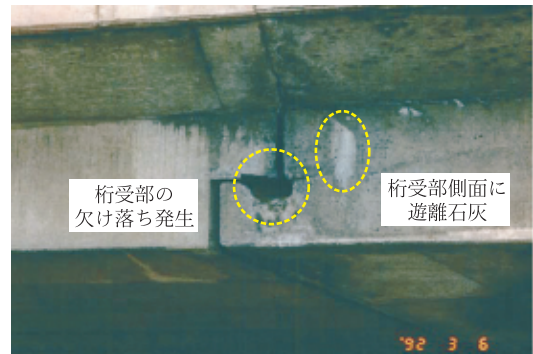
写真-5 桁受部の状況 (1992年)
