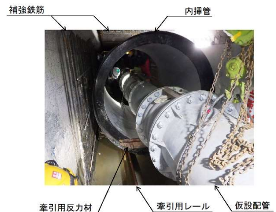
図-8 内挿管牽引作業状況
