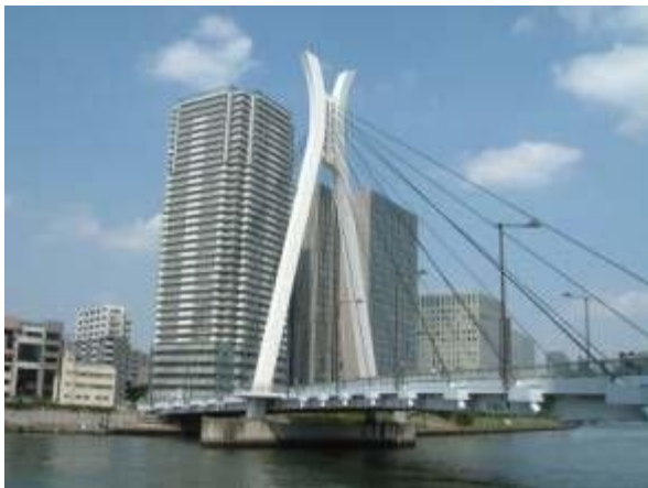
図3： 中央大橋(1992)不等二径間斜張橋 L = 71.4 + 137.9
