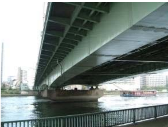
図5： 佃大橋(1964)鋼連続二箱桁橋 L = 86 + 90 + 86
