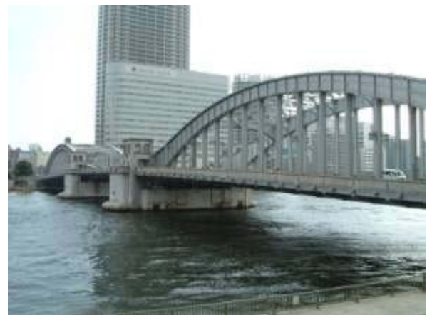
図6： 勝鬨橋(1940)跳開橋+タイドアーチ L = 86(\text{アーチ}) + 45.6(\text{跳開桁}) + 86(\text{アーチ})
