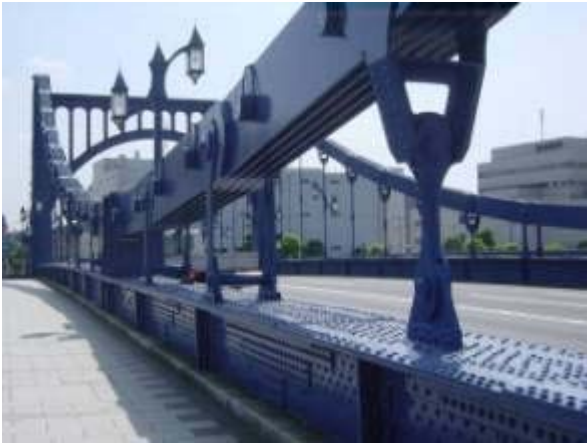
図1： 清洲橋(1928)自碇式チェーン吊橋 L = 45.72 + 91.44 + 45.72
