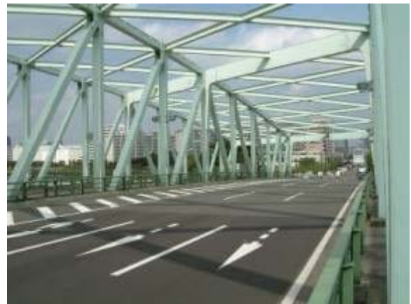
図4： 相生橋(1988 架け替え)連続トラス L = 41.25 + 66.00 + 41.25
