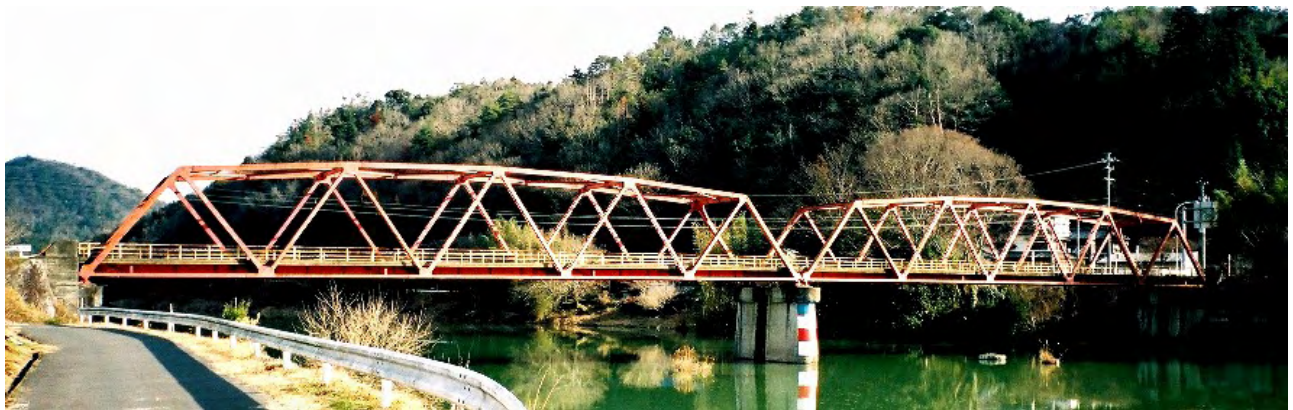
図 2： 下流側から見た加茂橋全景（愛知県主要地方道瀬戸設楽線 矢作川）
