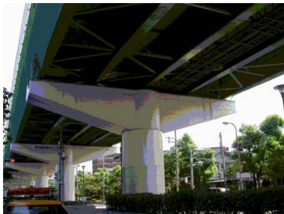
図3： 測定対象橋梁の主桁構造
